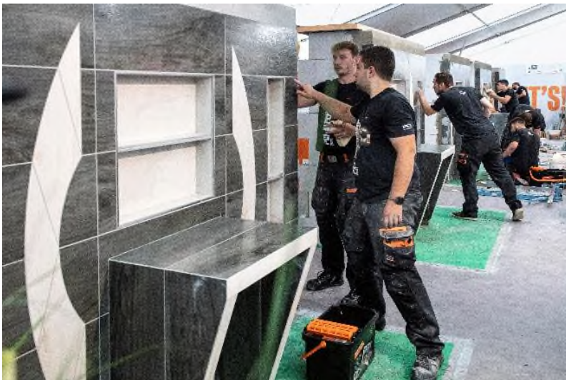
Der PCI-Alpencup 2021: anspruchsvolle Aufgabe mit großformatigen Fliesen und Segmentbögen (Link zum hochauflösenden Photo )
